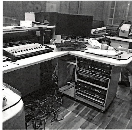
Consola instalada, limpieza de mobiliario y acomodo de cables.
