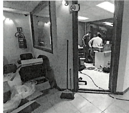
Desempaque de equipos identificación de cableado y conexión de blade de consola
