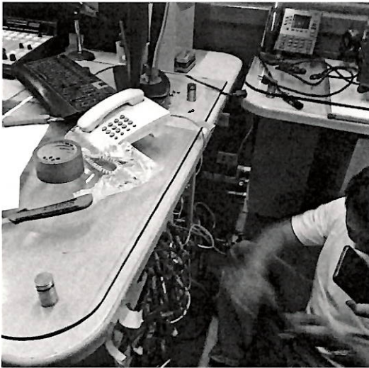
Retiro de consola y elaboración de cableado especializado para este equipo
