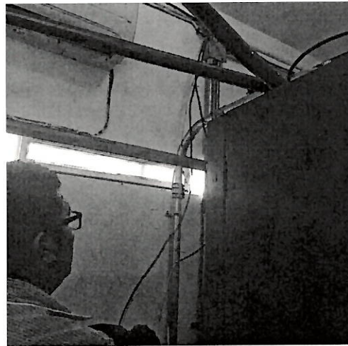
Se deja la conexión para alimentar el equipo de enfriamiento nuevo
