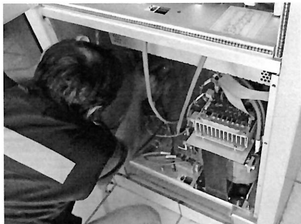
Limpeza del equipo transmisor y equipos periféricos
