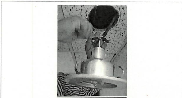
Remplazo de cableado para bases de iluminación.
