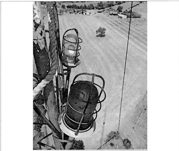
Se cambiaron cuatro focos de las luces de obstrucción de la torre de transmisión de Libres FM
