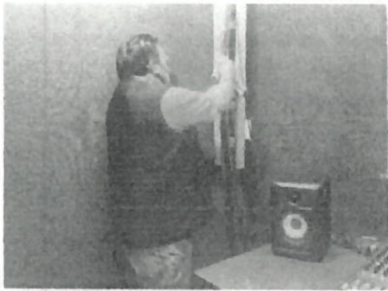
Limpieza de cableado
