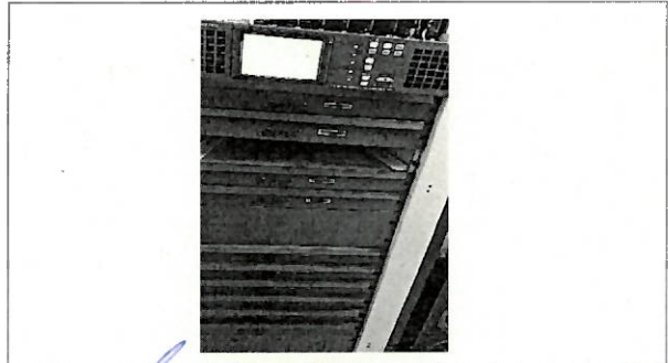
Niveles de potencia en norma y reflejadas correctas.
