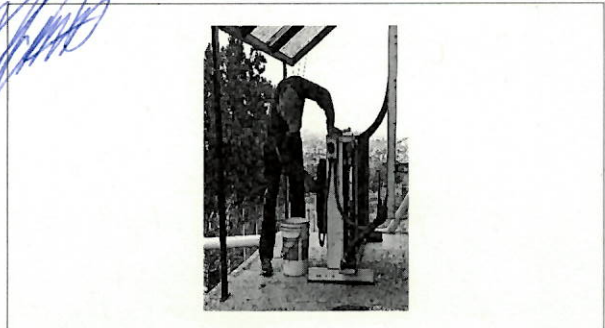
Limpeza al intercambiador de calor.
