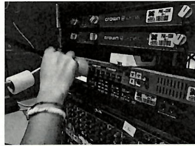
Limpeza de sistema de intercomunicación con las cabinas de producción y master
