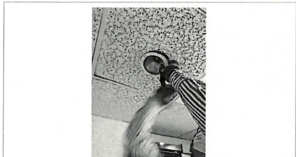
Cambio de bases para iluminación.
