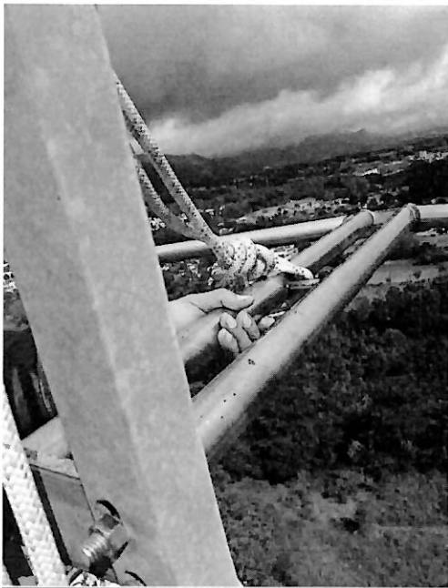
Se subió el elemento de la antena reparado, se fijó en la antena y se colocó cinta térmica.
