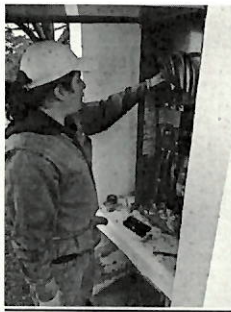
Instalación del interruptor.
