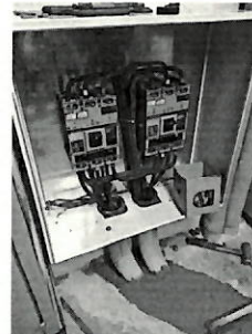
Instalación de "bypass" en el cerro Zapotecas.
