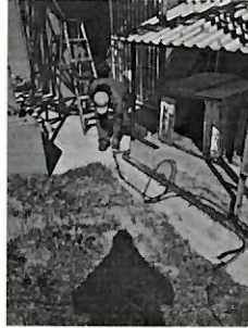
Instalación de cable de cobre para interruptores.
