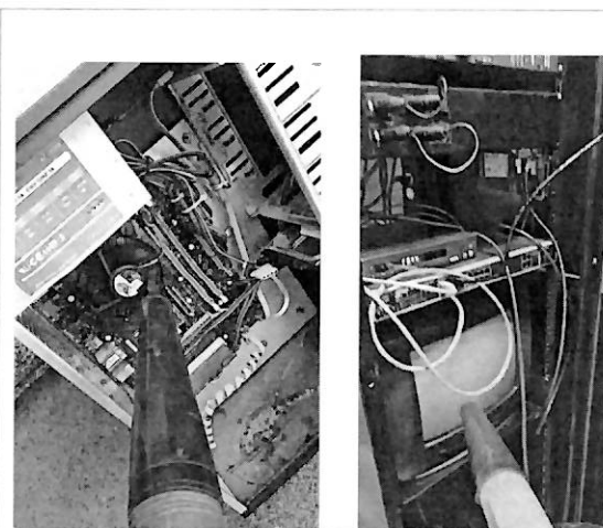
Limpieza de CPUS de las cabinas de transmisión, producción y limpieza y aspirado en cuarto de equipos de transmisión.
