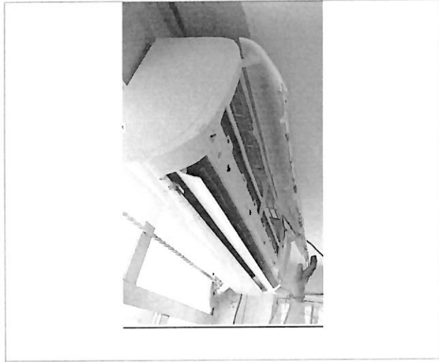
Aspiración de polvo y limpieza de los filtros del sistema de enfriamiento (clima)
