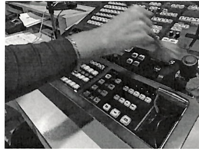
Limpeza del controlador del switcher.
