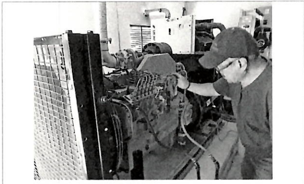
Se realizó mantenimiento preventivo de la planta de emergencia
