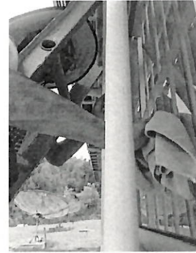
Se realiza limpieza de perímetro de estación (Ventanas).
