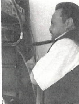
Limpieza y revisión de conexiones
