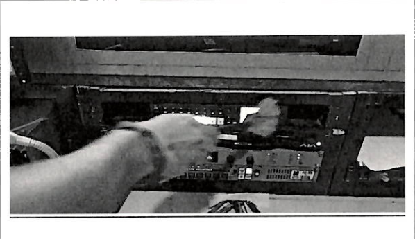
Limpeza preventiva al switcher auxiliar.
