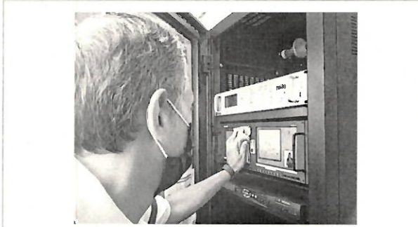
Limpeza de monitores de video del telepuerto.
