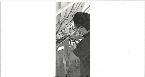
Ajuste de tornillería y chequeo de conectores en cable "RF" y aplicación de líquido anticorrosivo.
