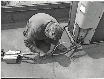
Cambio de válvulas para agua
