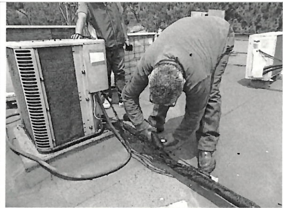
Aislamiento de mangueras y conexiones
