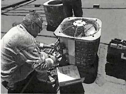
Cambio de conexiones que tenían fuga
