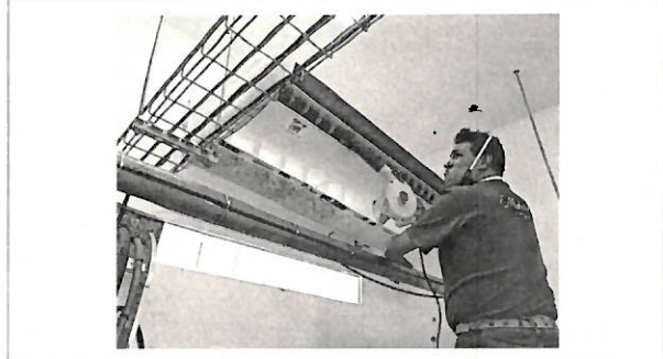
Limpeza con aire a presión al Split.
