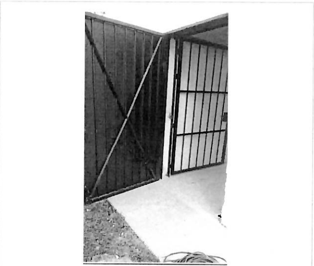
Se cambió la puerta de entrada a la caseta de transmisión, y se le coloca una reja interna.
