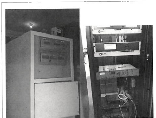
Limpeza del transmisor, y los equipos del rack de comunicación.
