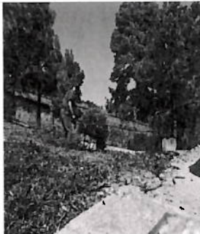
Se hizo limpieza y se retiró la hierba en el área de la subestación eléctrica
