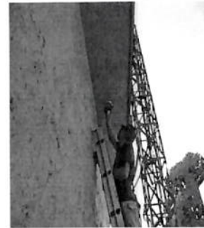
Se remplazaron los focos de la entrada principal de la subestación
