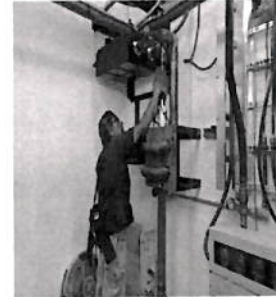
Se limpió la tubería del sistema de enfriamiento
