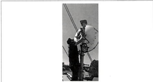
Ajuste de tornillos en el paneo de la antena
