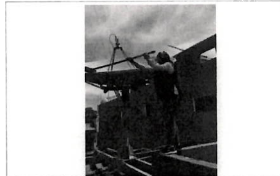
Limpieza de antena
