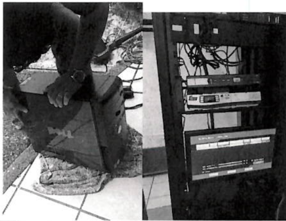
Se limpiaron los cpu's y los equipos en el rack de transmisión en estudios, se verifican parámetros del enlace satelital.
