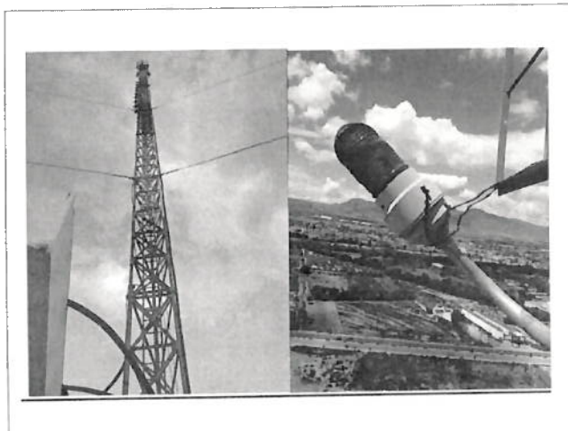
Revisión de estado de la torre de FM, y cambio de focos de las luces de obstrucción
